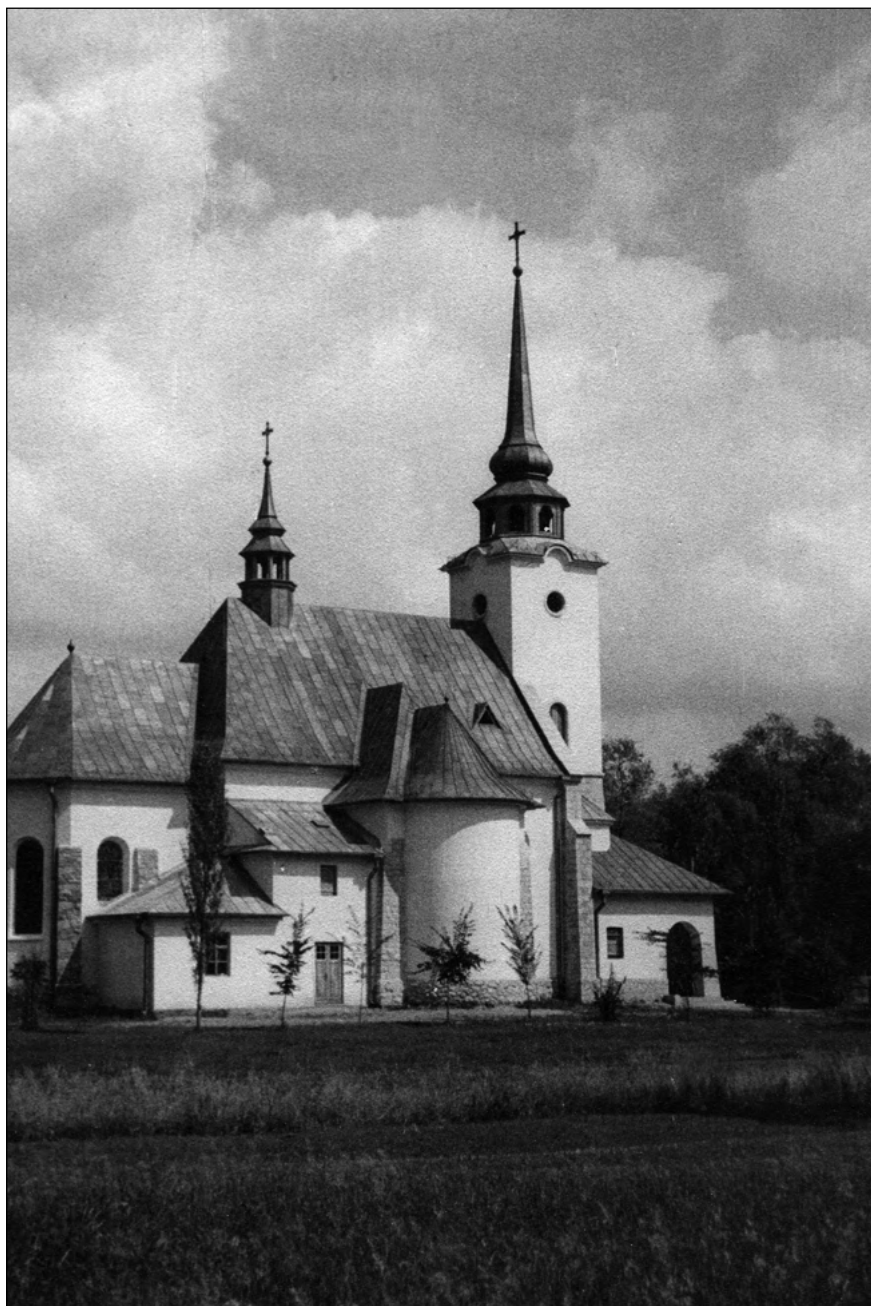
Kościół parafialny po zakończeniu budowy w 1937 r. Z Księgi parafii.
