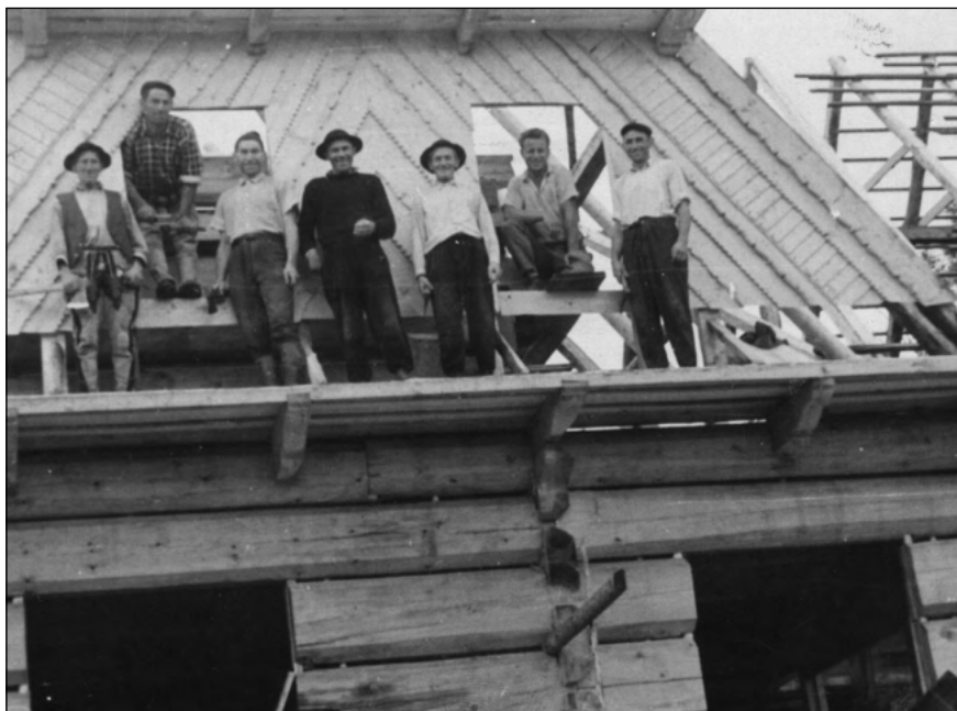
Budowa domu Świdrów-Zbójników.
