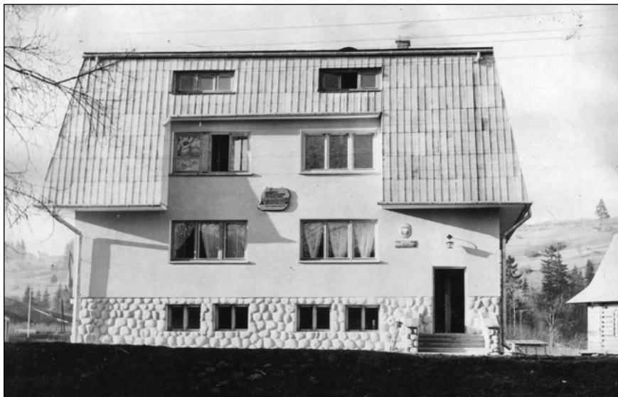
Budynek Ośrodka Zdrowia.
