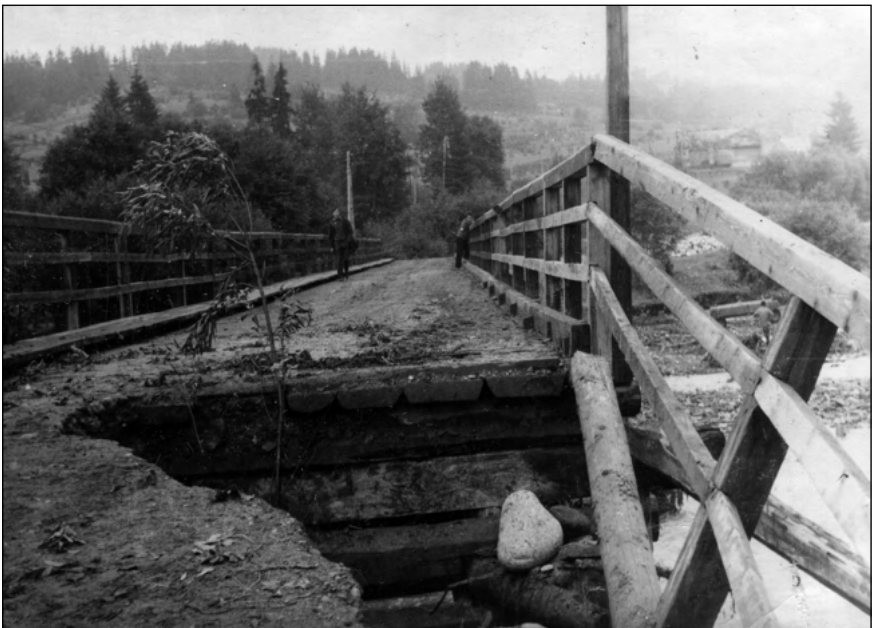
Powtórnie zniszczony przyczółek mostu do Gliczarowa.
