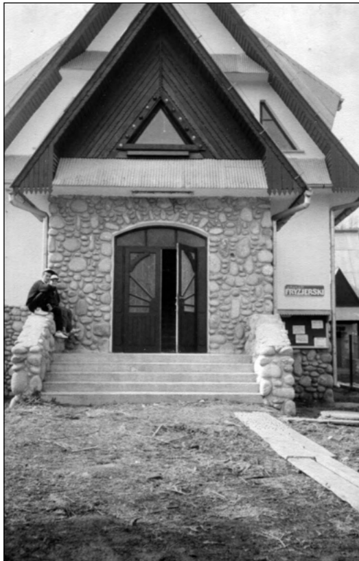
Budynek Gminnego Ośrodka Kultury.
