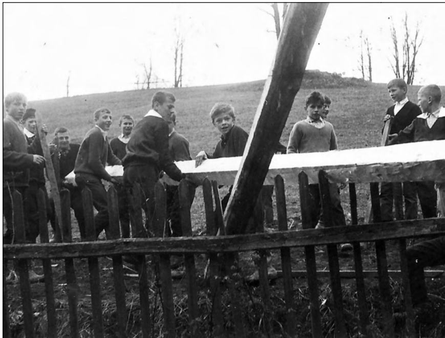
Uczniowie przy budowie szkoły w Gliczarowie Dolnym.
