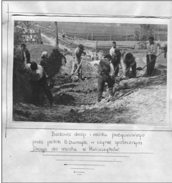
„Budowa drogi i mostu przegonowego przez potok B. Dunajec w czynie społecznym. Droga do mostu u Pańszczyków”. Z Kroniki Białego Dunajca Tadeusza Szeflińskiego.
